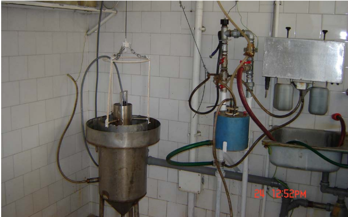
12. fénykép. Folyamatos és szakaszos mintavevő berendezés a szennyvíz-mintavevő állomáson
