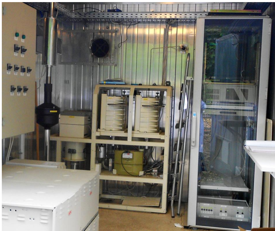
3. kép. A Referencia állomás belülről
