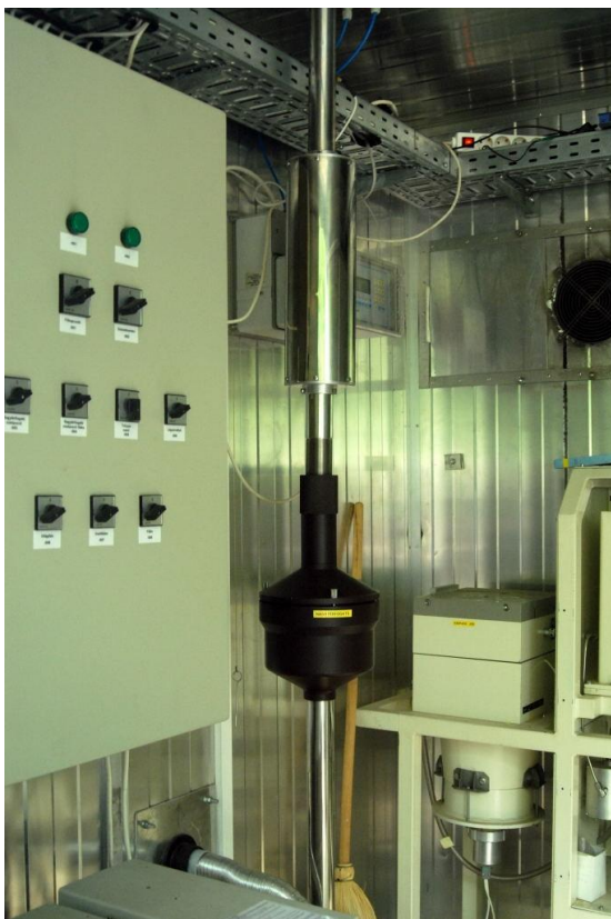
4. kép „A típusú” állomás nagytérfogatú mintavevő berendezése
