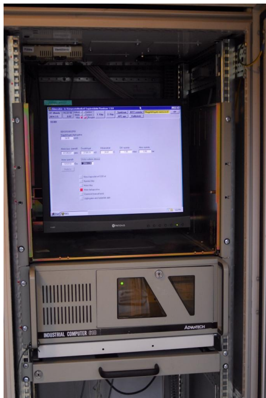
6. kép Az „A típusú” állomás vezérlőegysége és kijelzője
