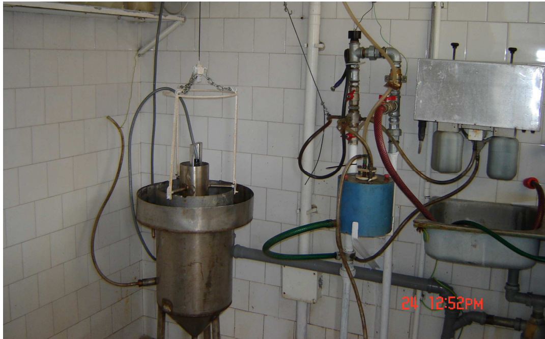
14. kép. Folyamatos és szakaszos mintavevő berendezés a szennyvíz-mintavevő állomáson
